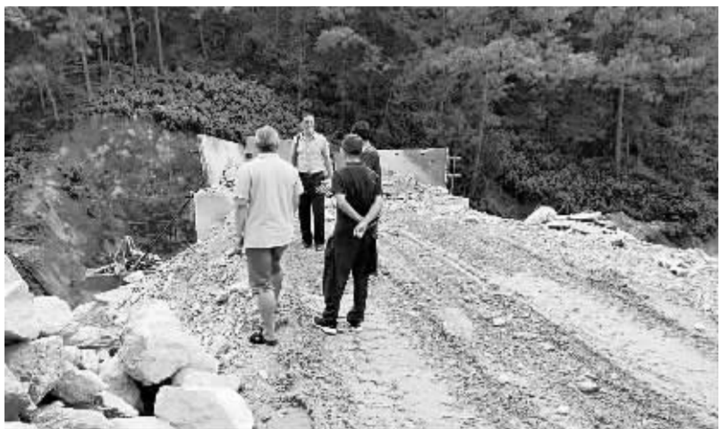
督查组深入施工现场进行检查督导。
