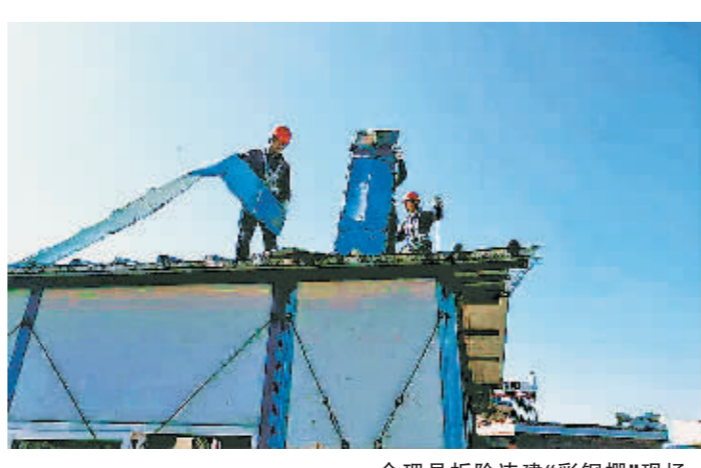
会理县拆除违建“彩钢棚”现场。
