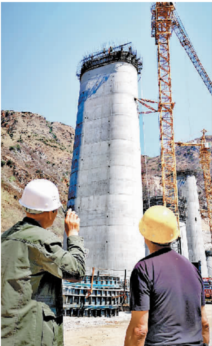
成昆铁路峨米段六标段的铁路建设者正在为位于甘洛县苏雄乡埃岱村境内的尼日河2号双线特大桥梁安装桥墩模板。
